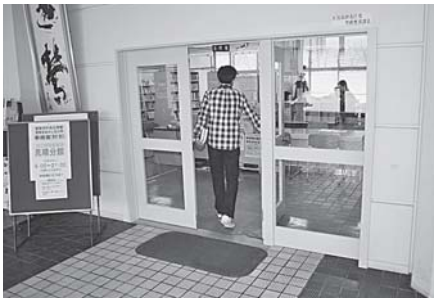
公民館のわかりにくくて暗い入り口の間口を3倍に広げガラス張りで明るくした
