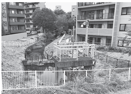
豊平川の堤防の内側にある創成川の取水口はマンションに取り囲まれている。ここが創成川の始まり地点。堤防の外側（川側）にも水門があつて豊平川の増水に備えている。付近は歴史的にも豊平川防災の重要ポイントだ
