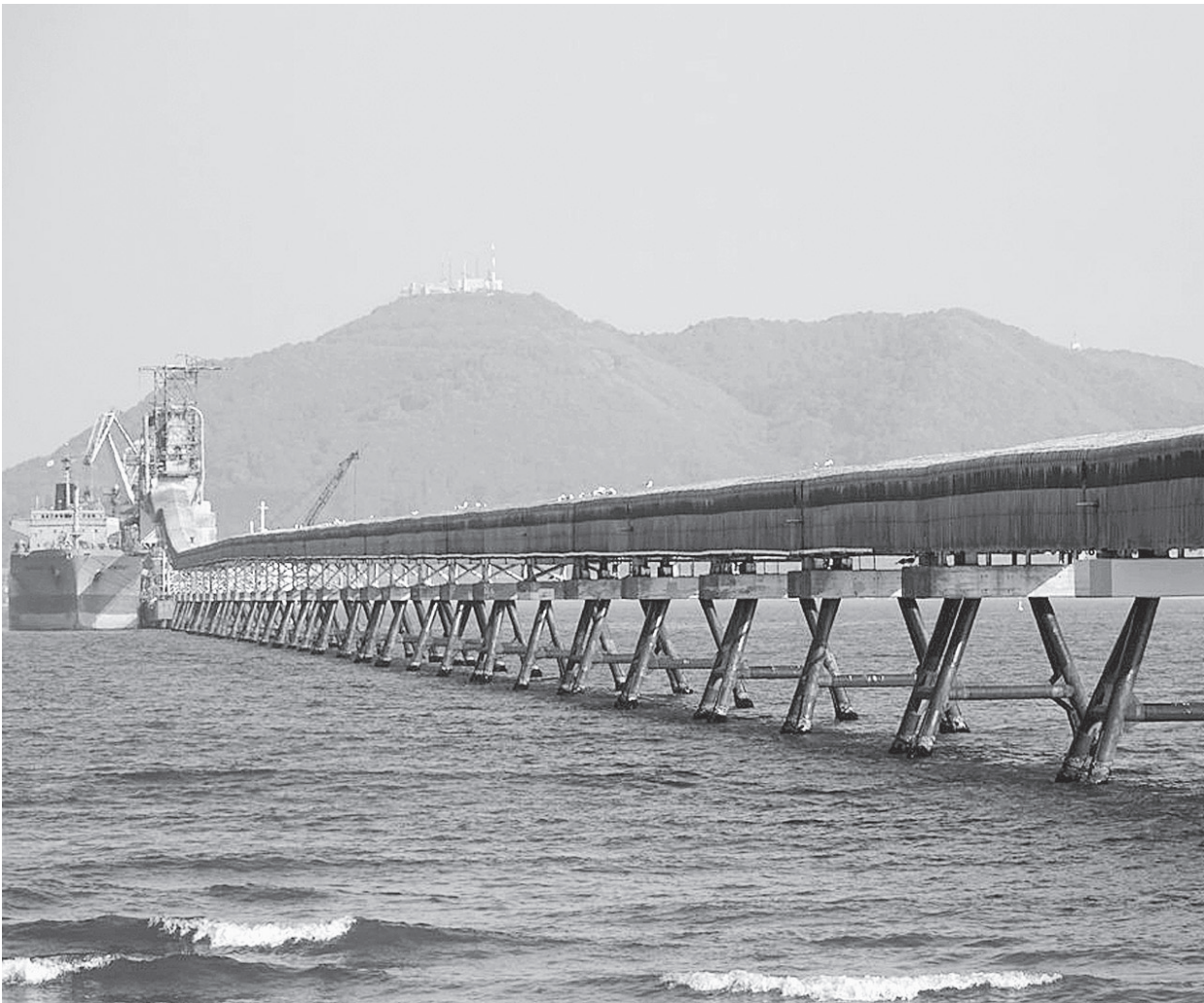
北斗市上磯の海岸から函館湾に突き出す太平洋セメント上磯工場の海上栈橋。タンカーが4隻が着棧でき、製品のセメントや、原料や燃料の石炭などを積み卸しできる2本のパイプ状コンベヤーが通っている
