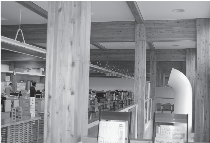
町有林のカラマツ集成材で建設された町役場庁舎内。カラマツ材の柱や梁（はり）がみえる。冬は木質ペレットの床暖と地熱利用の換気チューブ=写真右=で温かい
