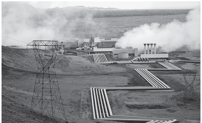
アイスランドで最大の地熱発電所「ヘトリスヘイジ」。むき出しのパイプが熱湯を運んでいる（筆者撮影）
