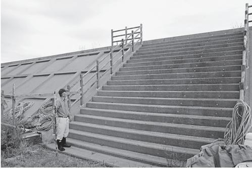
写真6 堤防は総延長約14\*<sub>0</sub>（島の周囲80\*<sub>0</sub>）。最大約12\*<sub>0</sub>。家の前の道路からは海が見えない。
