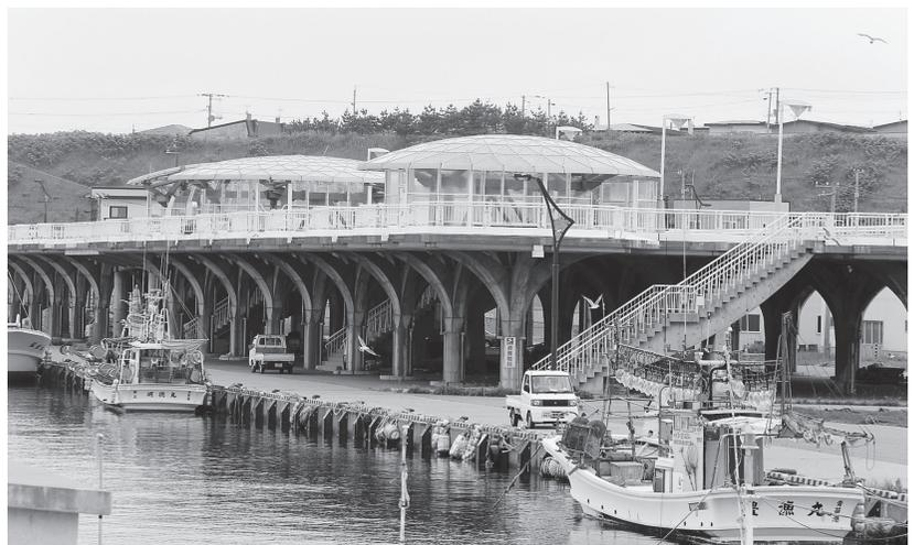
写真8 青苗港に整備された高さ6mの人工地盤。作業中に被災したとき、上に逃げる。
