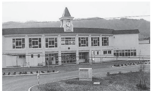
災害公営住宅建設事業として新設した公営住宅と火口近くから移転改築した洞爺湖温泉小学校。
