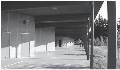
小学校内部。教室は非常時に生徒が逃げやすいよう平屋で広い校庭に向かってドアがある。
